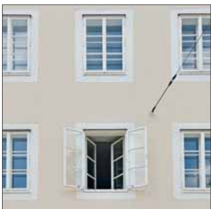
Abbildung 1 Kastenfenster in einem Gebäude in Salzburg. Die zarte Fenstergeometrie ist in beiden Stockwerken zu sehen, die untere Fensterreihe ist mit Vakuumglas ertüchtigt.
